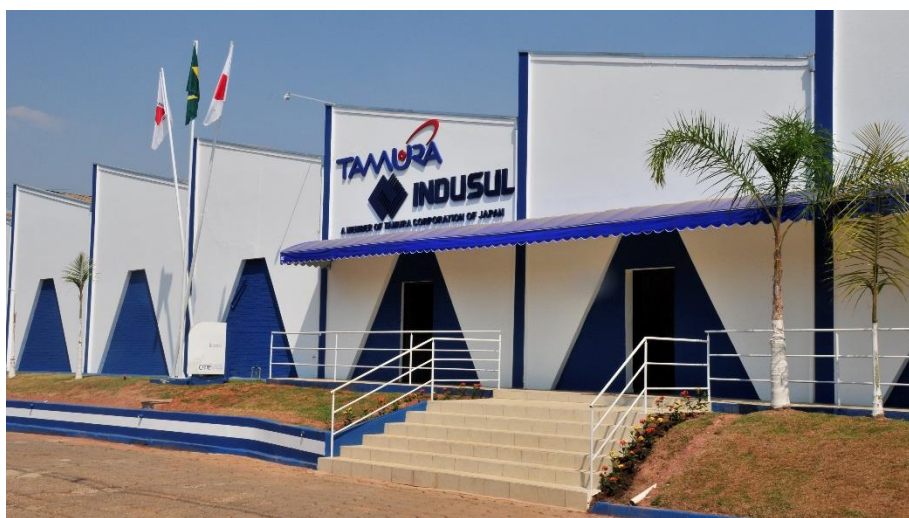
Indusul Indústria de Transformadores LTDA
